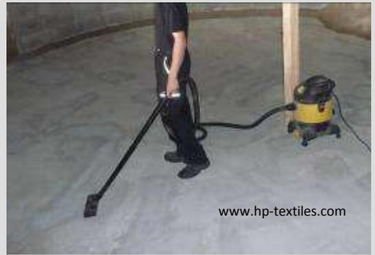
Abb. 9: Absaugen der Betonoberfläche
