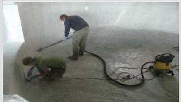
Abb. 43: Vollflächiges Anschleifen nach Aushärtung des Laminates.
