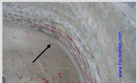
Abb. 6: Ausarbeitung der Eckbereiche (Hohlkehle)
