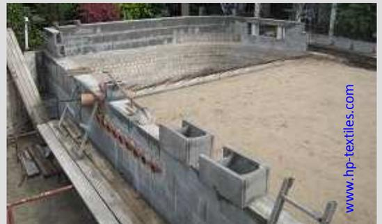
Abb. 4: Konstruktion mit Stahlbeton und Betonschalungssteinen
