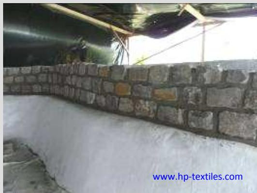
Abb. 49: Eine Natursteinmauer auf der Beckenbeschichtung (ohne Topcoat)
