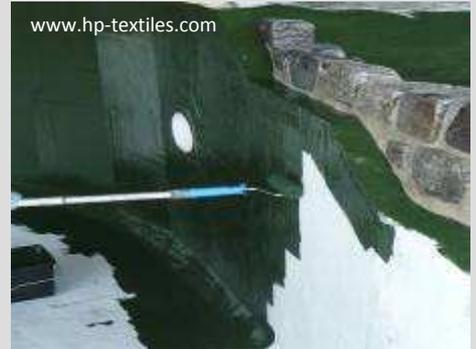
Abb. 44: Topcoat auftragen mit Rolle...
