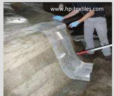
Abb. 36-38: Arbeiten an Übergängen Wand zu Boden
